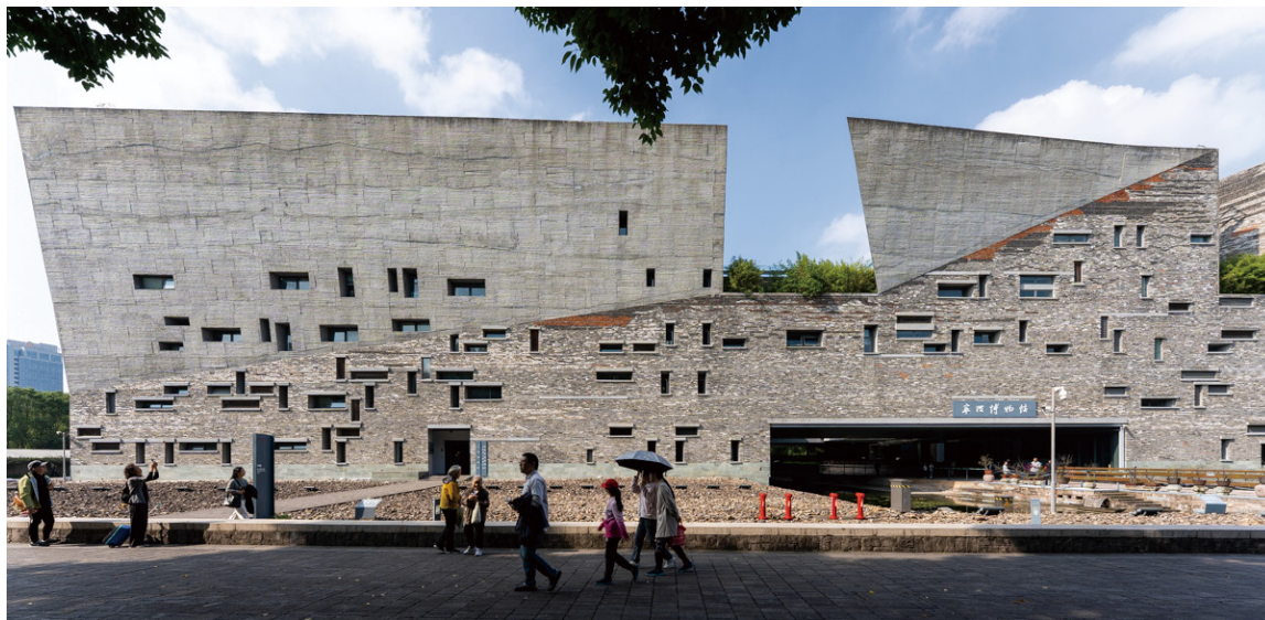
寧波博物館 2008年竣工 浙江省寧波市 延床面積 30,000 m 2 撮影：富井雄太郎
