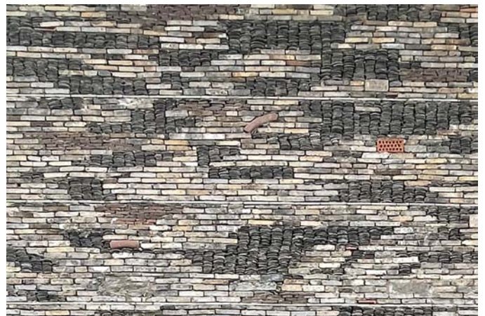
瓦片壁(わーばんへき) 解体された集落から廃棄されたレンガや瓦を集め再組積して作られるファサード
